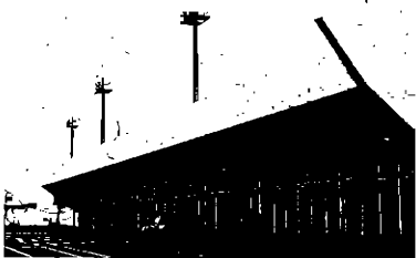
Aeroporto de Goiânia – módulo em operação
