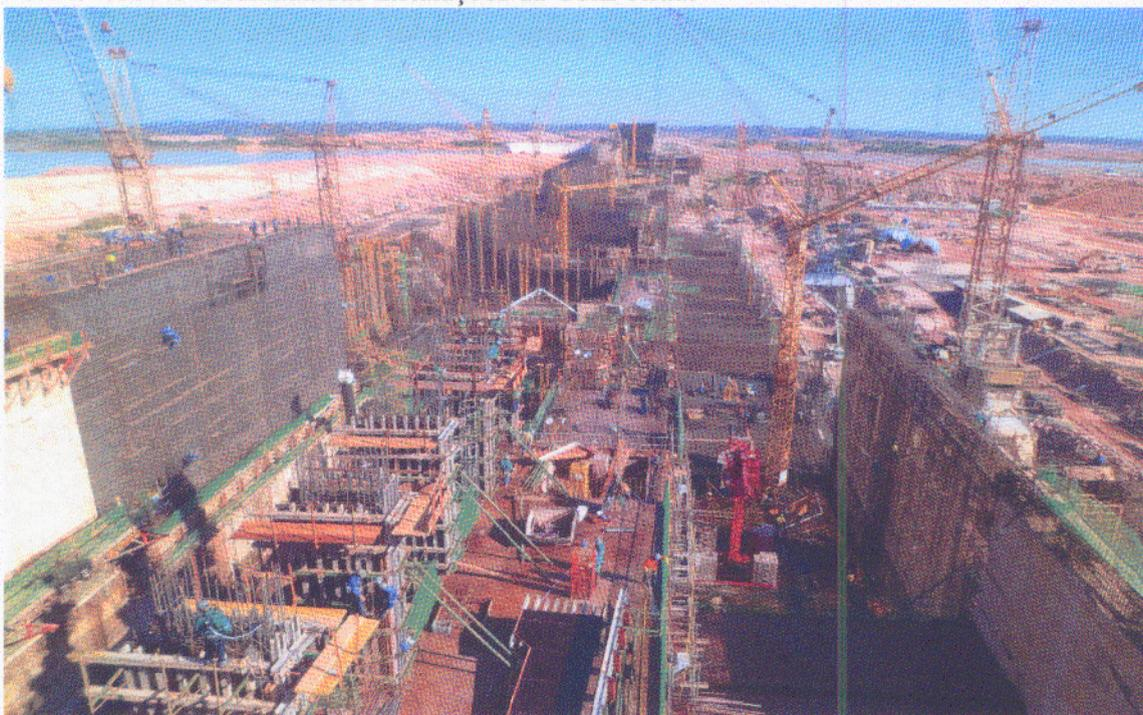
Foto nº 16. Vista aérea da construção do principal parede de contenção da UHE-Jirau.
