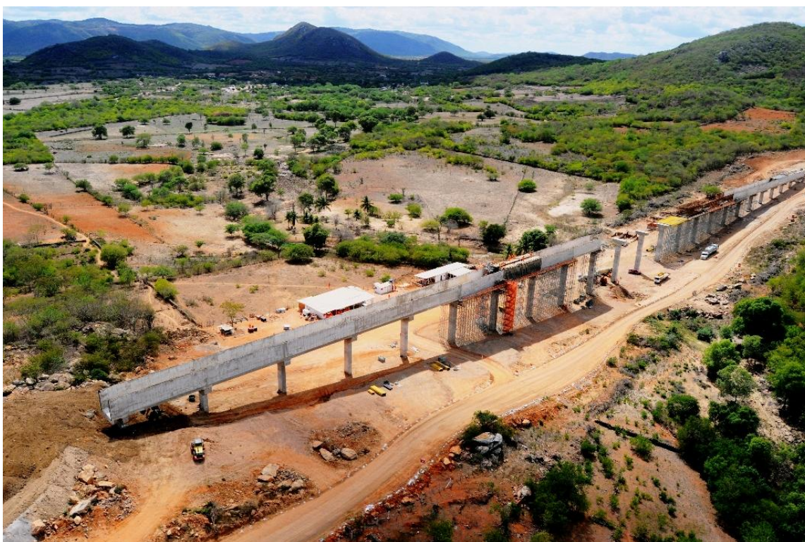
Figura 6 – Obras de ponte-canal no trecho 2
