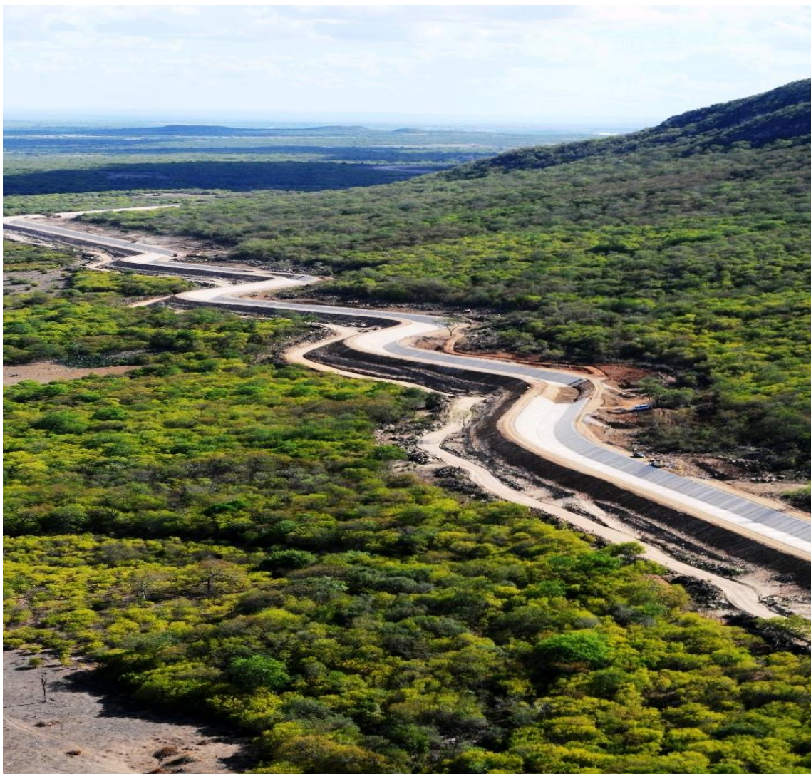
Figura 1 – Vista aérea do trecho 1 do Canal Adutor do Sertão Alagoano
