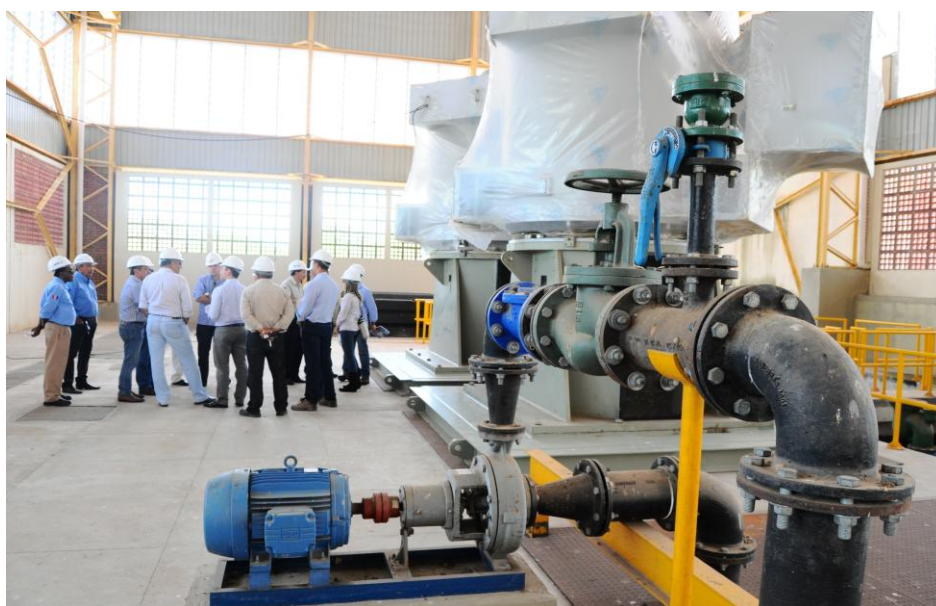
Figura 2 – Estação elevatória e casa de bombas
