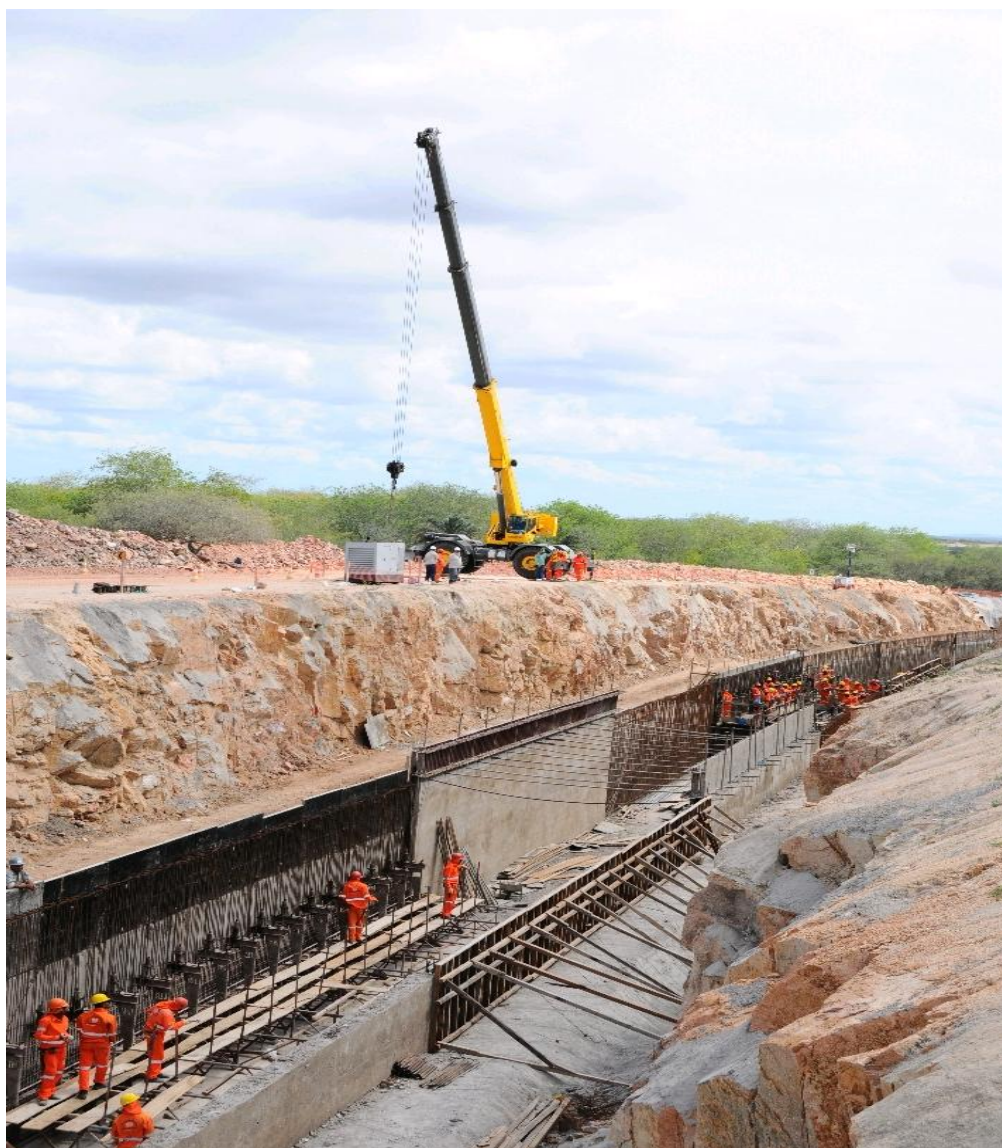
Figura 4 – Obras de construção de canal retangular no trecho 2
