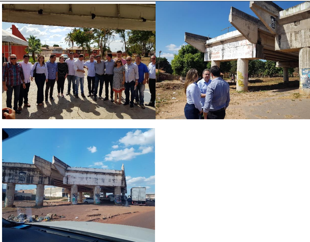
Almoço com a Comunidade de Tianguá e depois vistoria nos viadutos inacabados da BR 222
