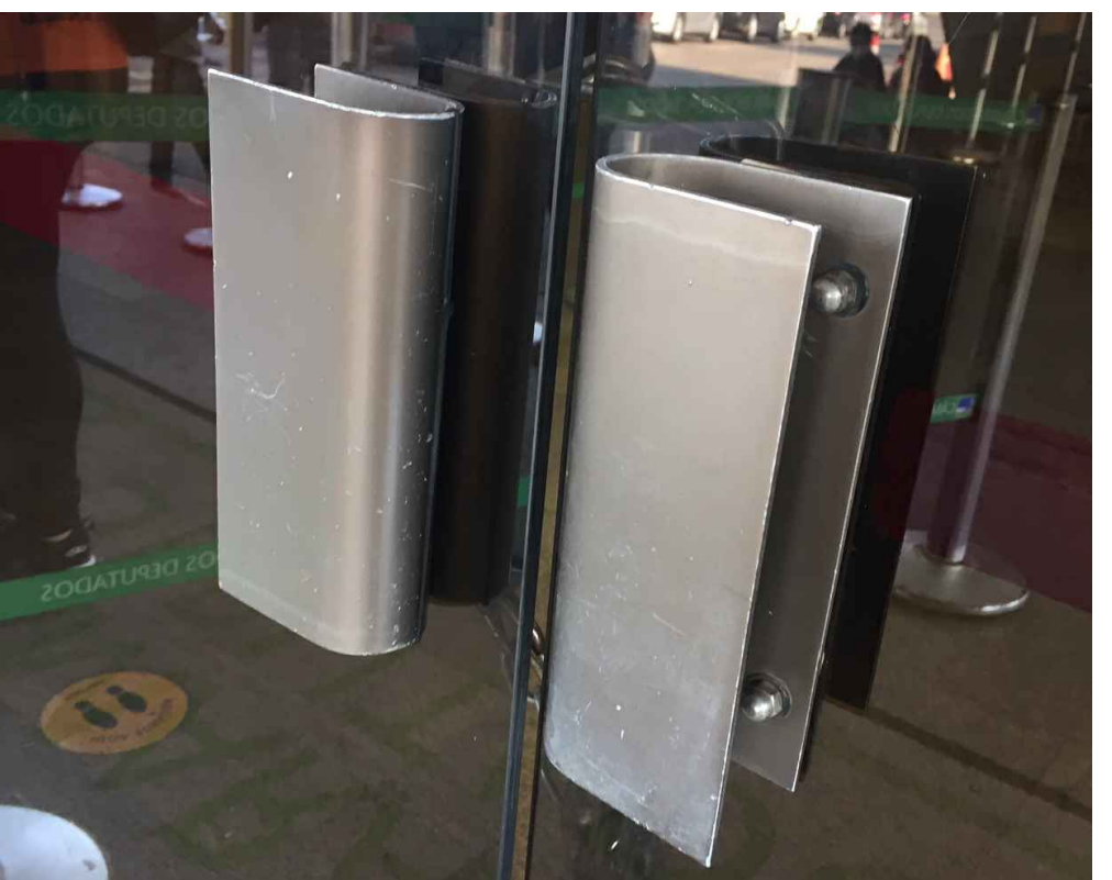
Anexo IV - Esquadrias Foto 03 - Puxador padrão existente escala: unidade:
