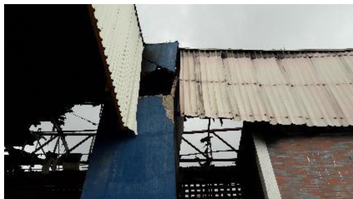
Foto 17: alvenaria colapsada após o incêndio.
