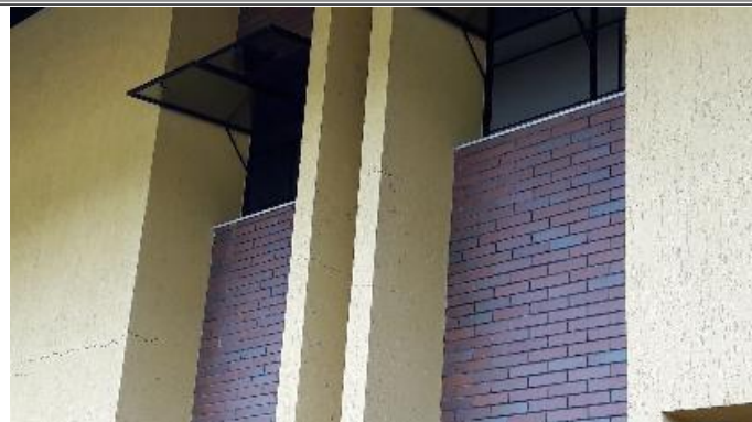
Foto 16: rachadura/trinca ocorrida na junção da estrutura com alvenaria após o incêndio.
