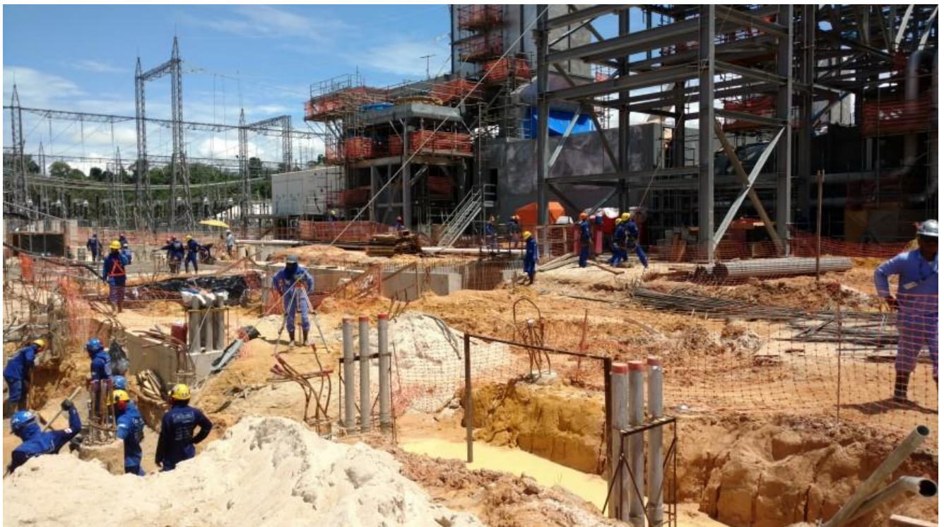
Escavações para a implantação de sistemas
