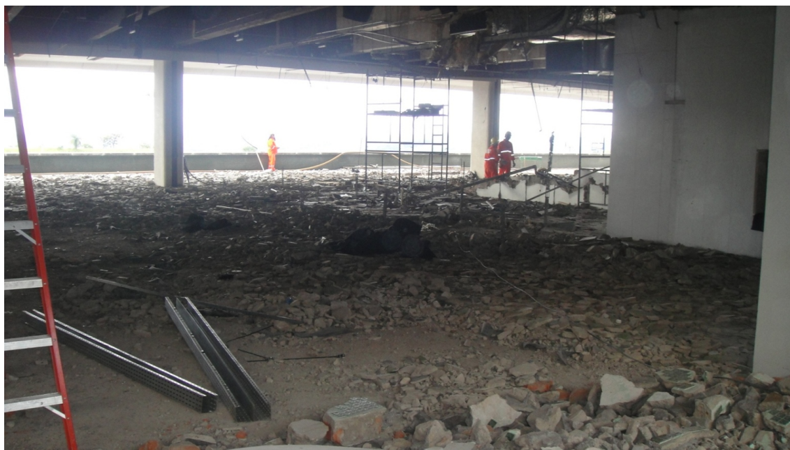
Demolição do piso do terraço
