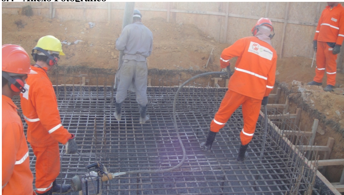
Concretagem Bloco Reservatório
