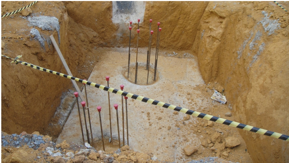
Fundação - Marquise metálica I
