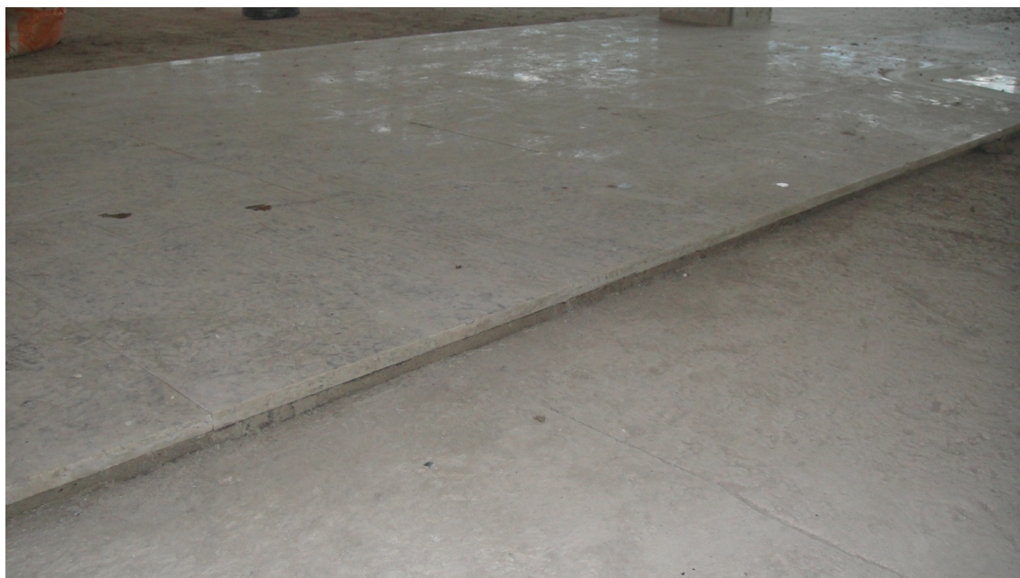
Granito colocado no Terraço
