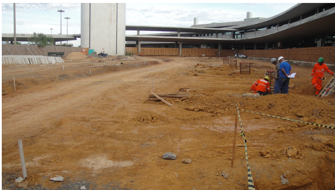
Linha de Pilares - Marquise externa
