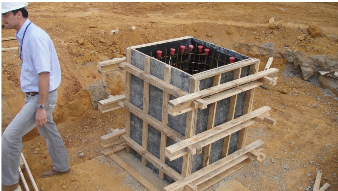
Fundação - Marquise metálica II
