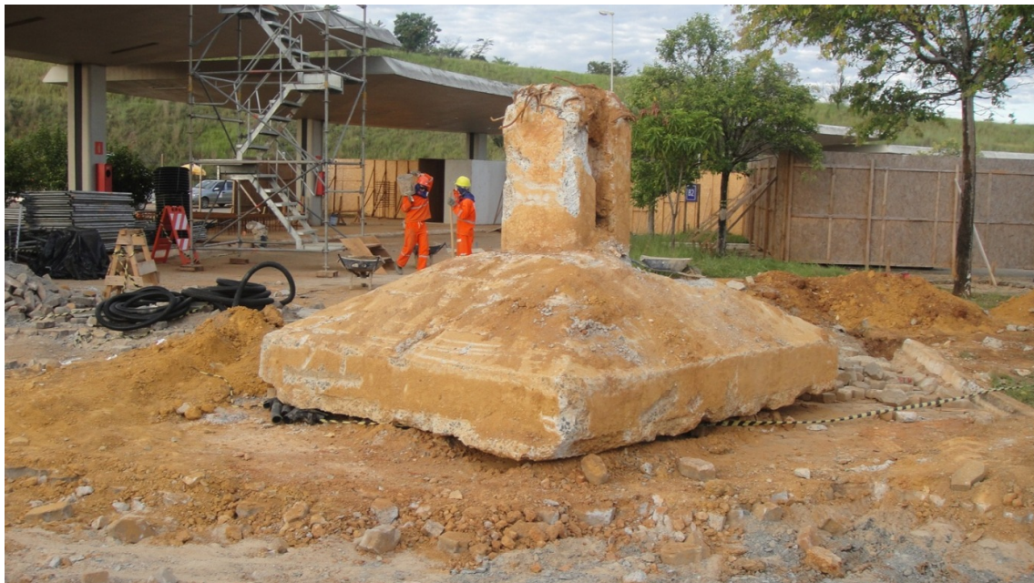
Sapata da marquise existente - retirada
