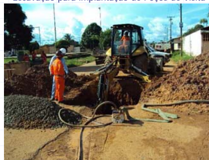
Escavação para implantação de Poços de Visita
