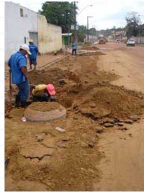
Reaterro de valas
