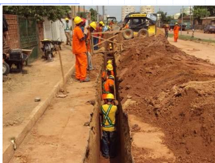
Escavação de valas
