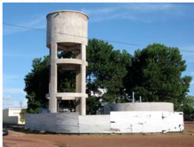
Reservatório construído antes da paralisação
