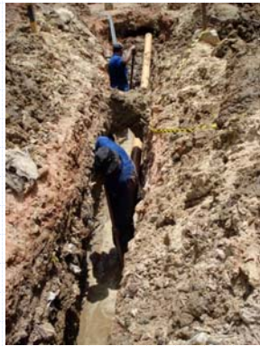
Escavação de valas
