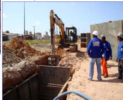
Escavação e escoramento de valas
