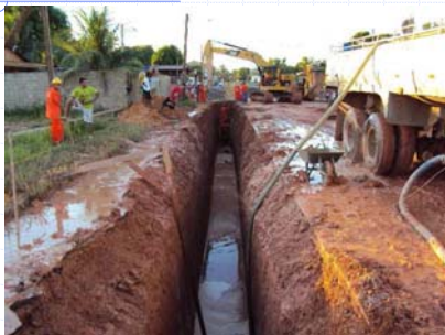
Esgotamento de valas
