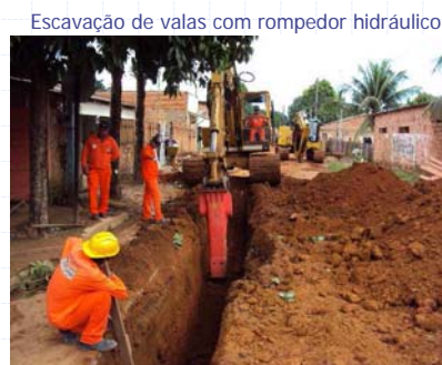
Escavação de valas com rompedor hidráulico
