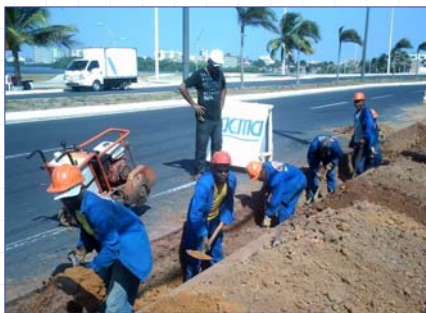
Recorte de pavimento e escavação manual de valas
