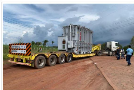
De acordo com o coordenador da bancada, deputado Hiran Gonçalves, o transformador é novo e saiu nesta sexta-feira de Miranda (MA) para Boa Vista. – Fotos: Ascom ParLamentar
