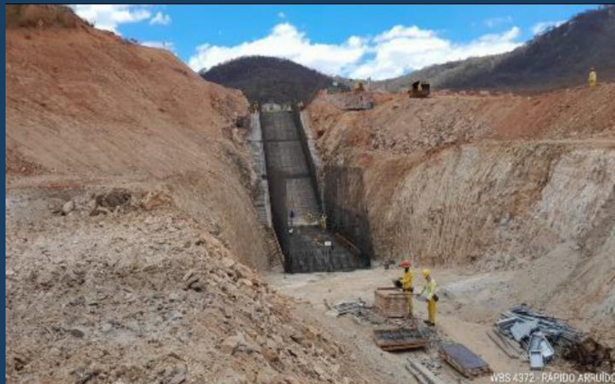
Rápido Arruído: Armação e Forma da laje inferior da Bacia de Dissipação
