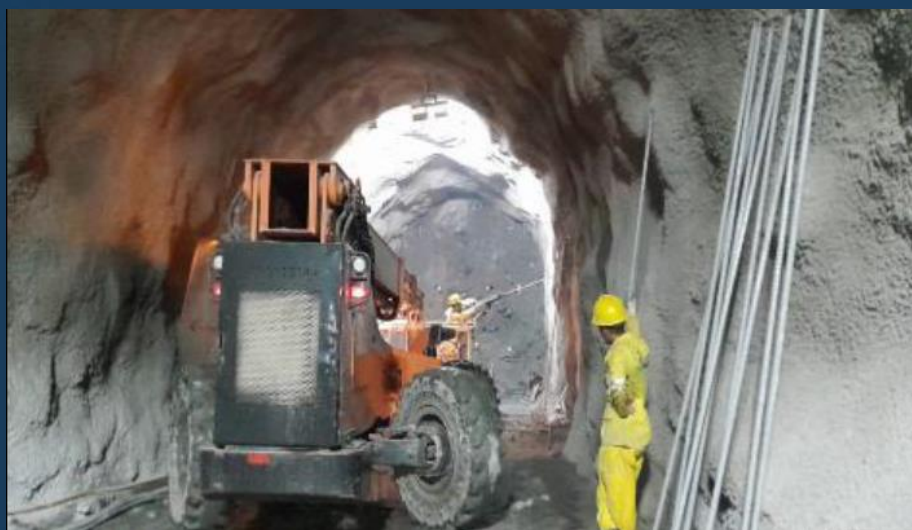
Túnel Major Sales: Execução da escavação com bate choco no sentido Emboque do túnel
