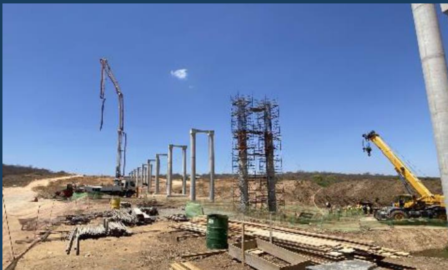
Aqueduto Bananeira: 4ª Etapa dos pilares
