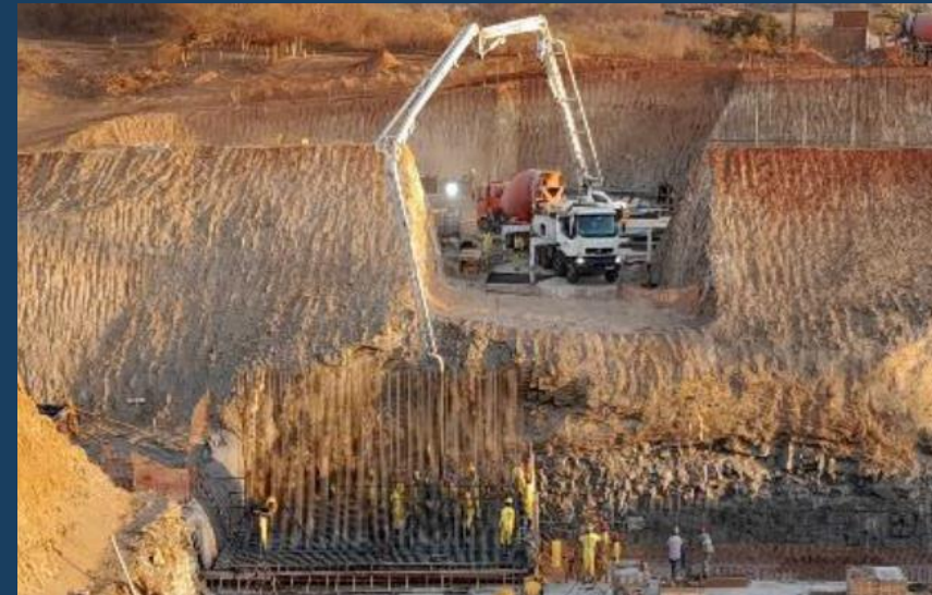
Concretagem do Muro Lateral esquerdo do Vertedouro
