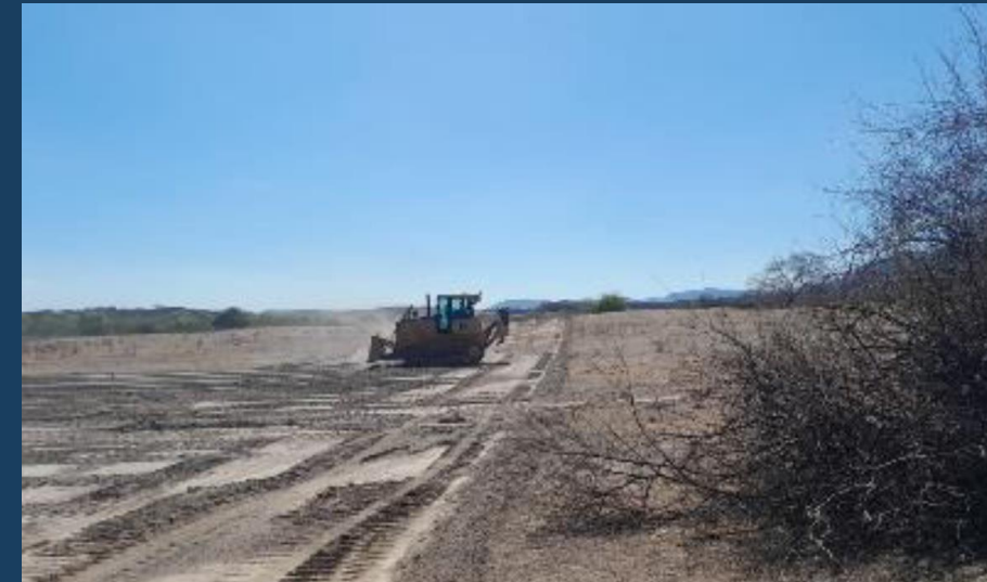
Execução de Supressão Vegetal
