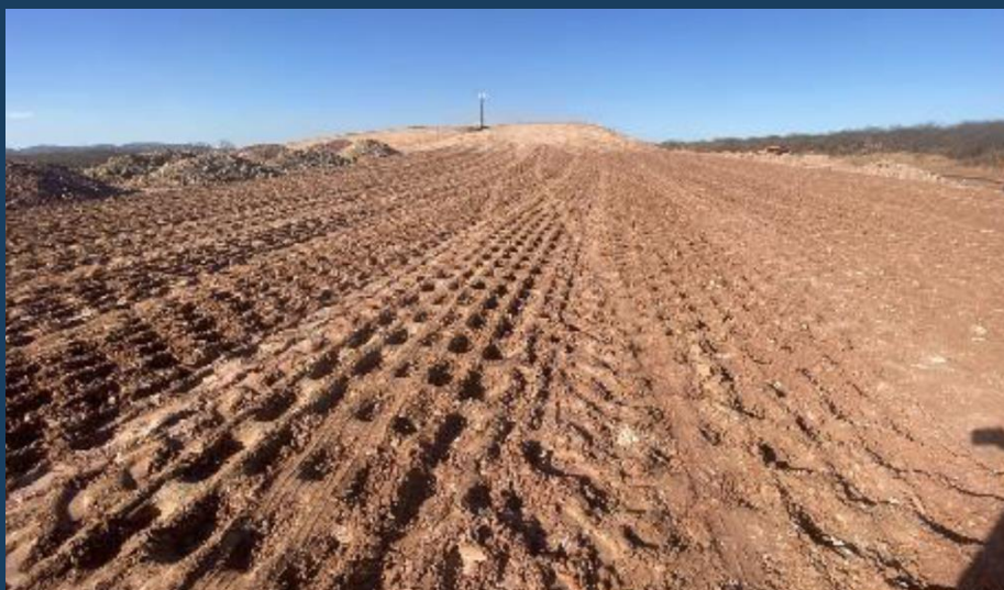
Execução de Aterro Compactado
