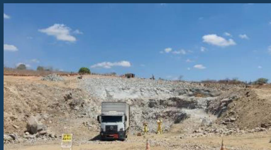
Desmonte de Rocha no Emboque do Túnel
