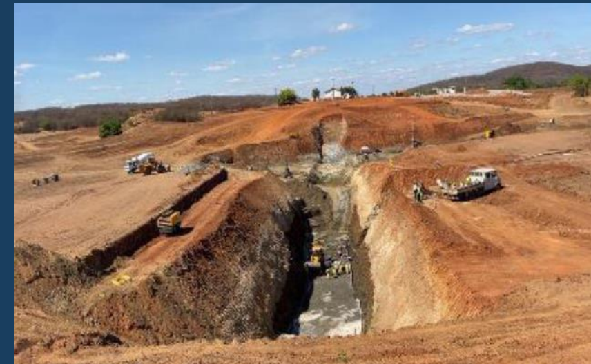
Regularização do Muro Lateral do Vertedouro
