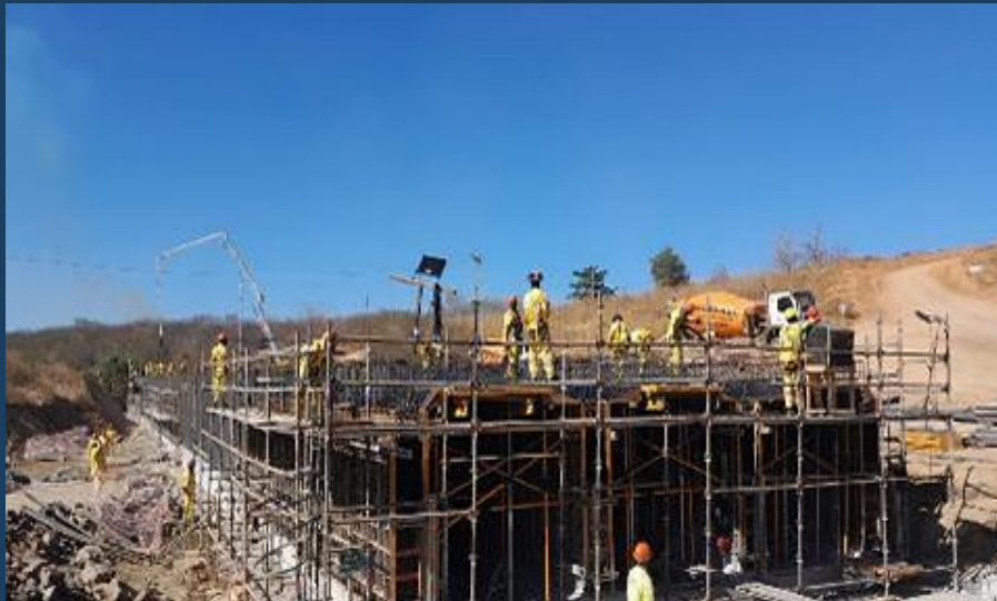
Bueiro 01: Montagem da ferragem da laje superior do módulo 01
