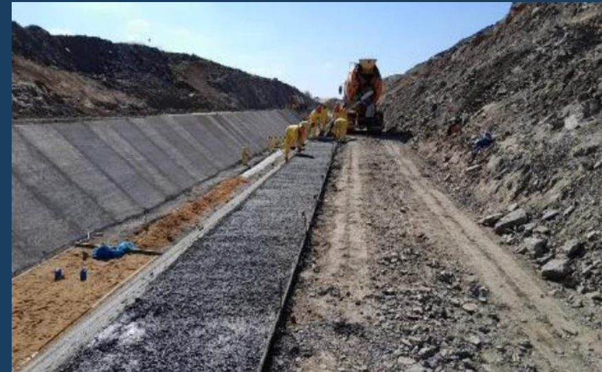
Canal C3: Execução de ensaio para liberação de aterro compactado
