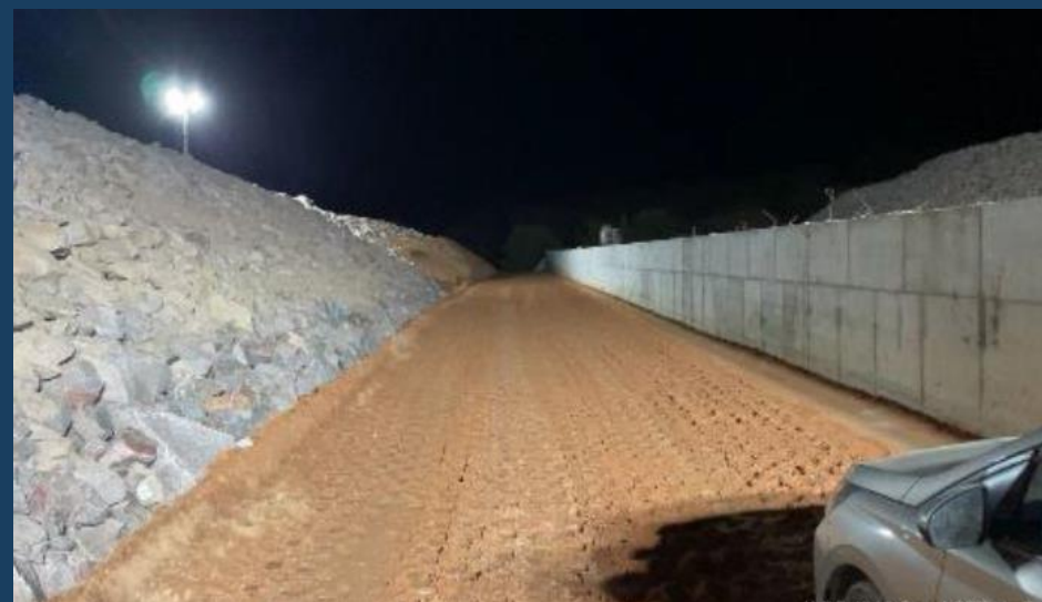
Execução do Bueiro 02
