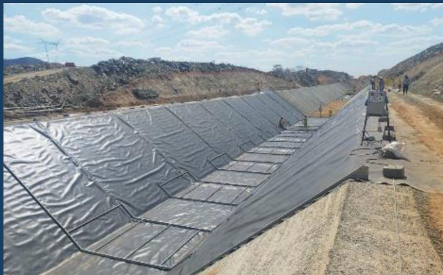
Execução da Geomembrana
