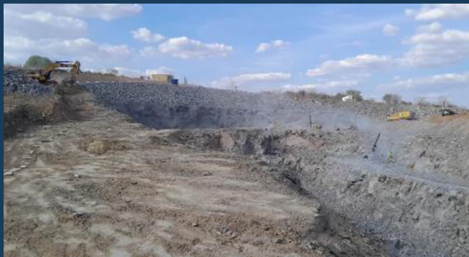
Execução da escavação no Emboque do Túnel
