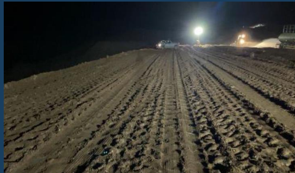
Canal C2: Execução de Aterro Compactado
